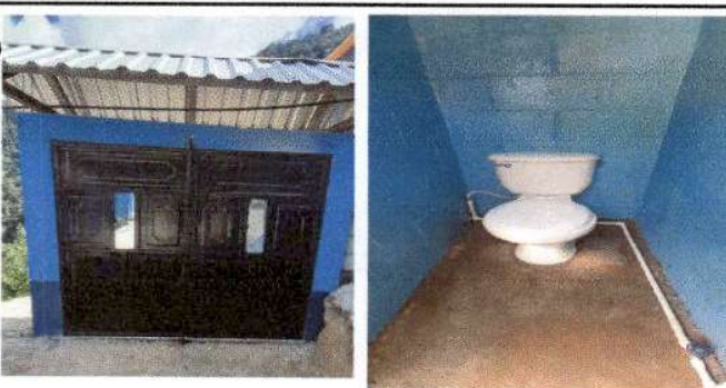
Foto 5: sustitucion de portón e Inodoro
