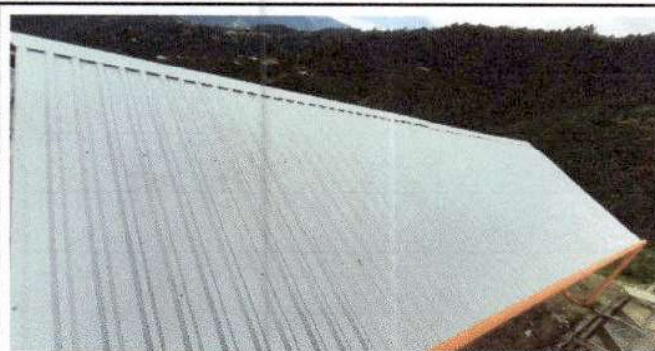
Foto 2: Sustitucion de lámina, por lámina troquelada aluzinc
